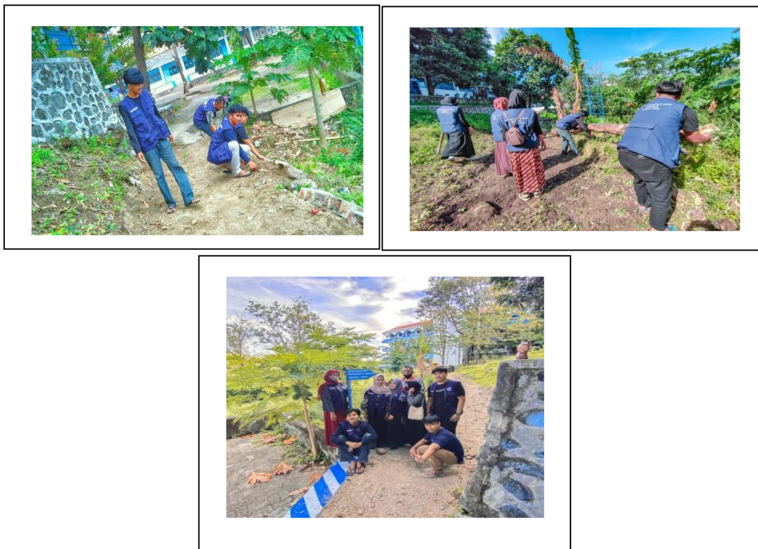
Gambar 2. Pelebaran Jalan menuju Green House dan pembuatan pondasi jalan
